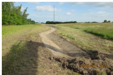
Bassin ved gl. renseanlæg graves
